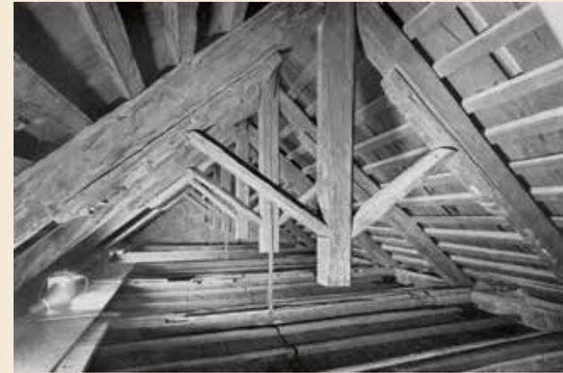
Aufnahme der Gebindestruktur des Kirchendaches des Sinaiklosters (Hängewerk mit Streben), Weite des Mittelschiffs 5,50 m, 6. Jh. n. Chr. (Forsyth 1973, Plate DXXXII A.).
